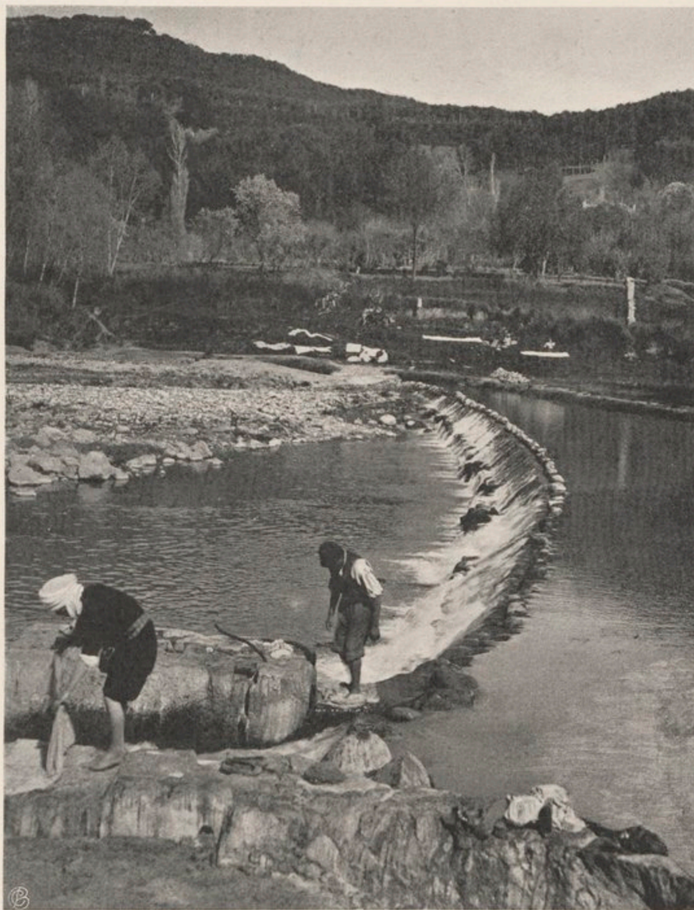
Barrage du Rummel, à Constantine.
