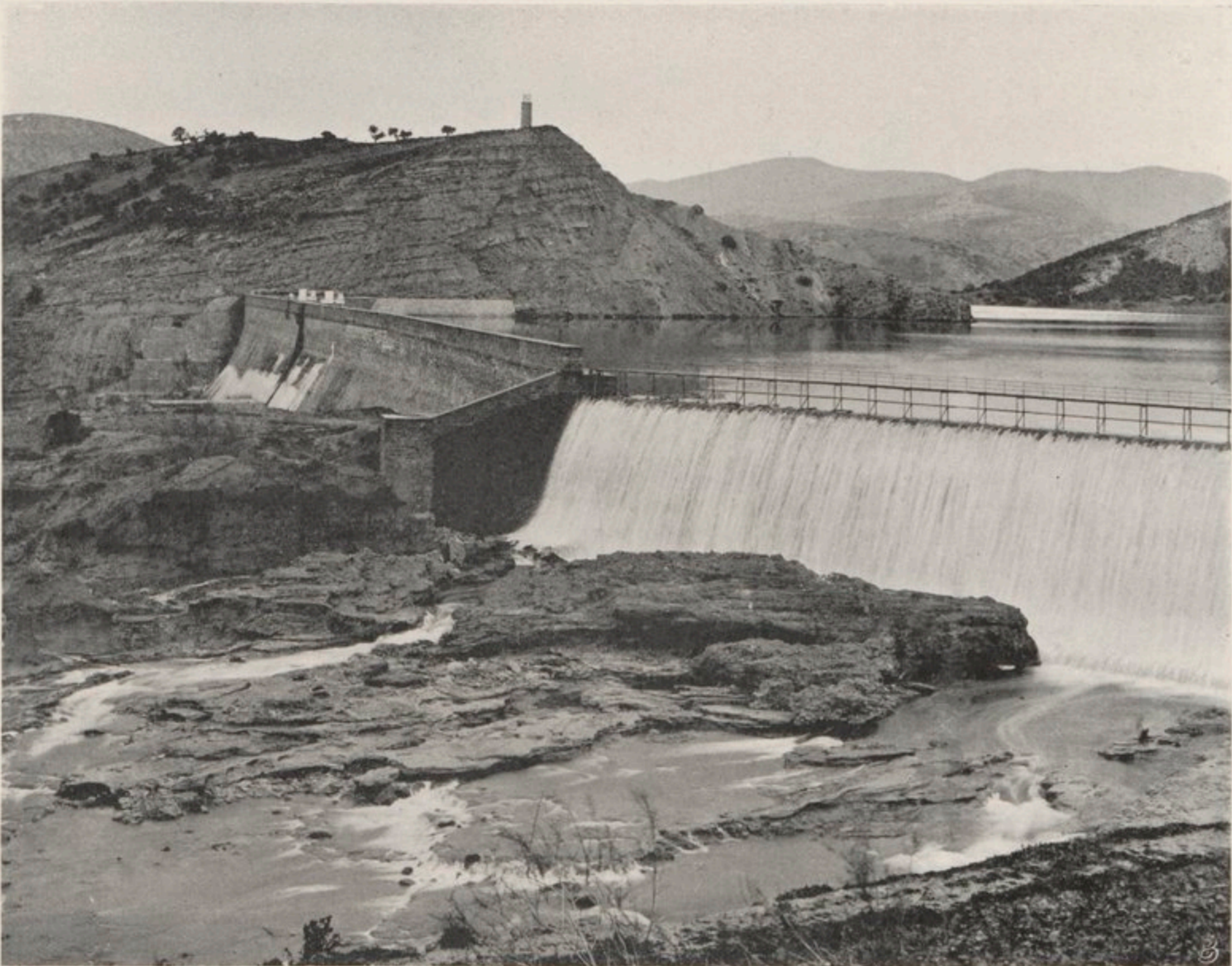
Barrage de Perrégaux.
