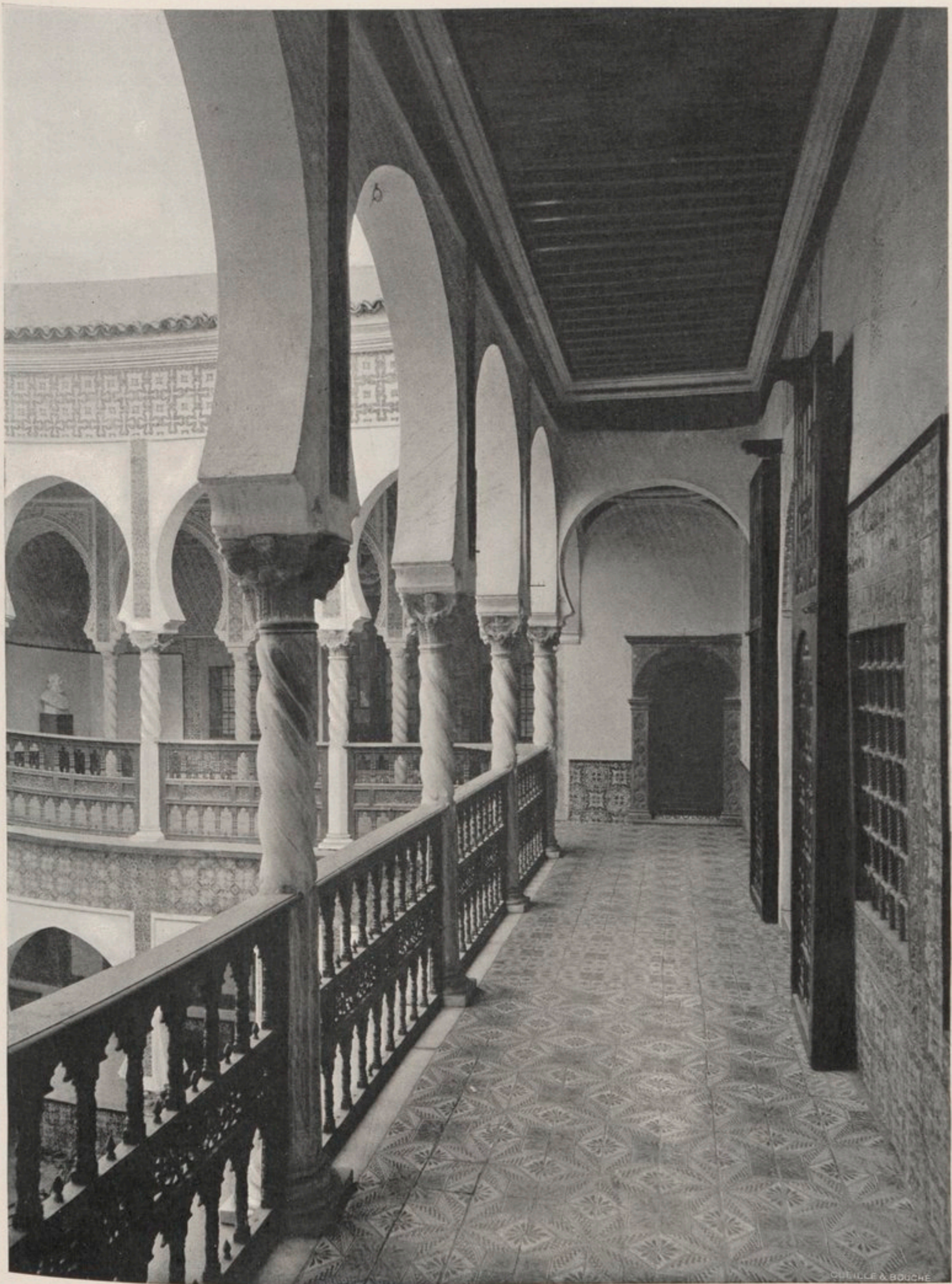
Détail de la galerie de l'archevêché d'Alger.
